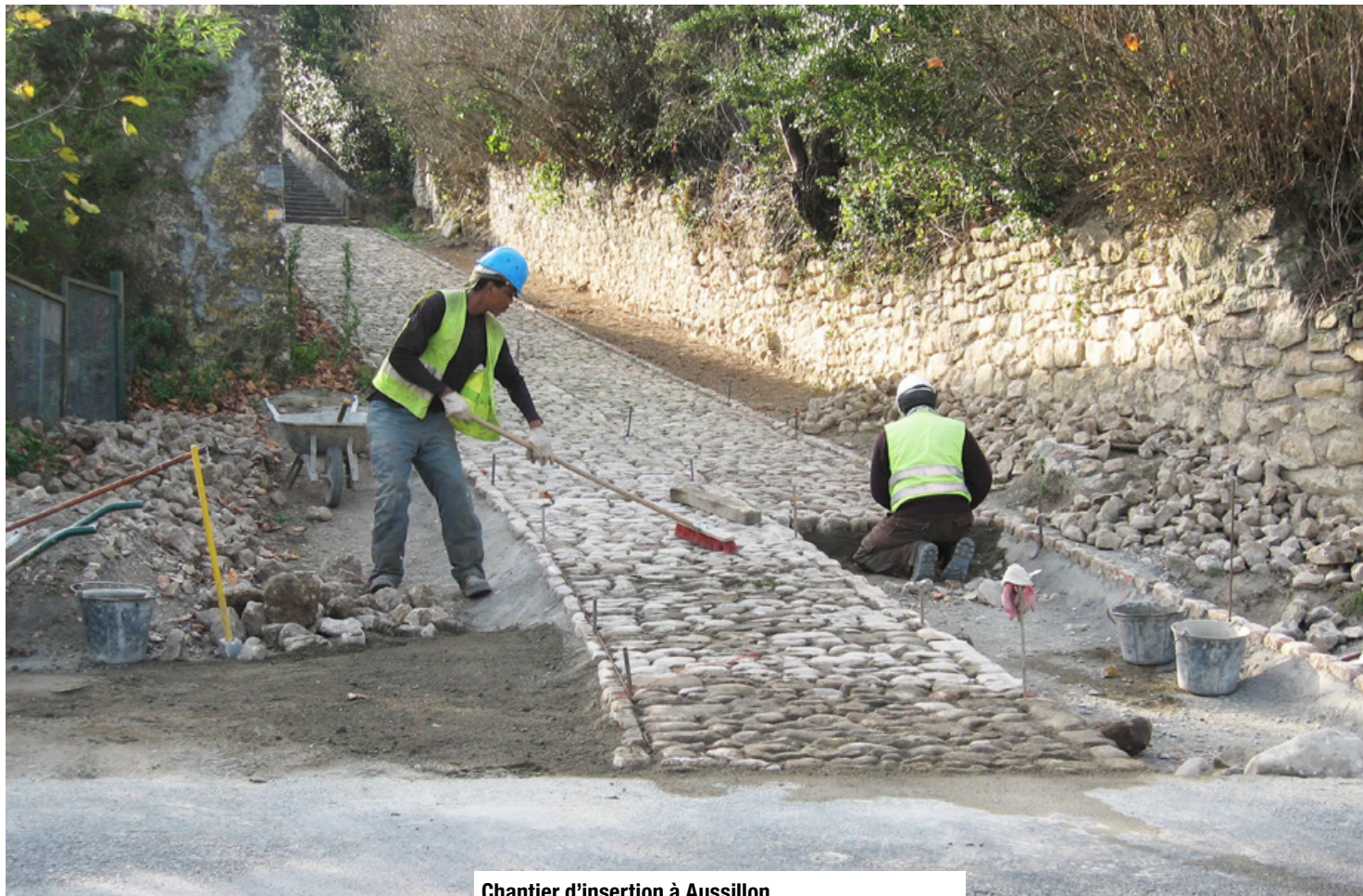
Chantier d'insertion à Aussillon.
