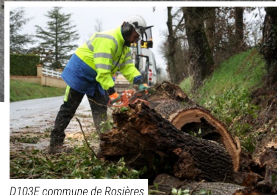
D103E commune de Rosières
